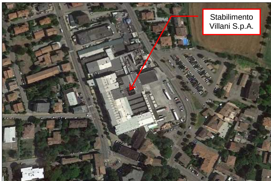
Vista aerea dello stabilimento
